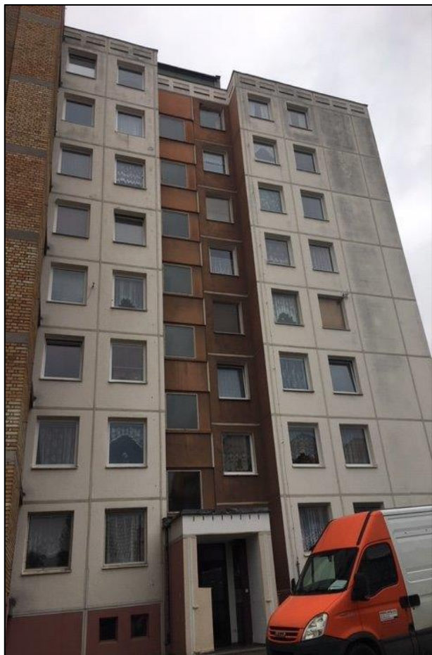
stav před rekonstrukcí
